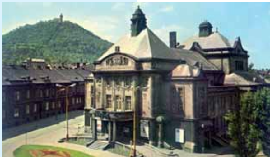
Il teatro nella Most vecchia prima della demolizione
