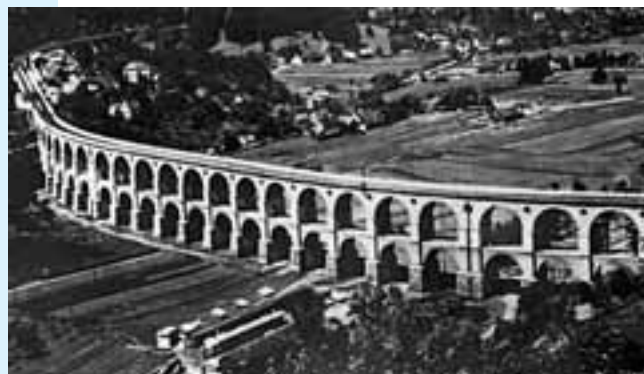
Viadotto di Borovnica
